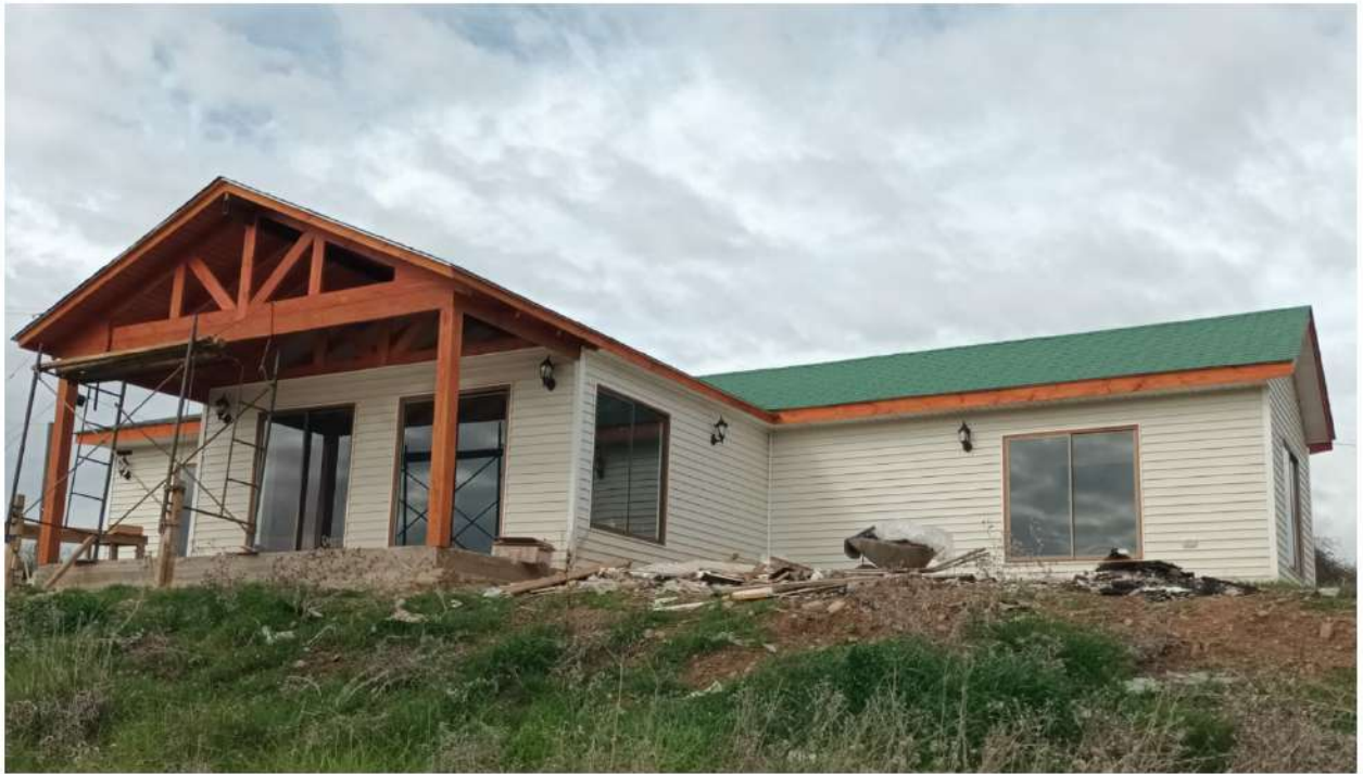
Techumbre en teja asfáltica
