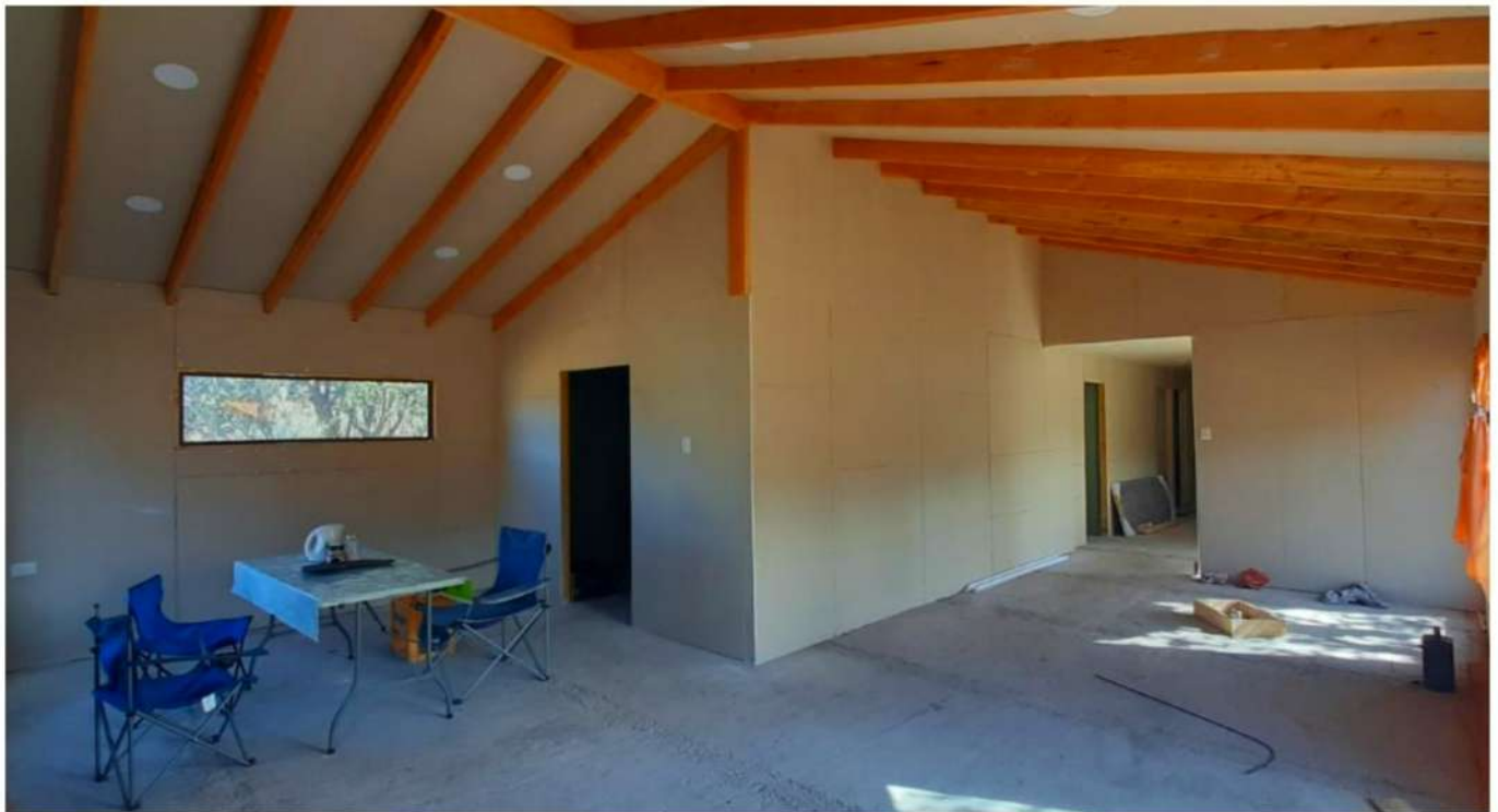
Forro de divisiones interiores por una cara en volcanita de 10 mm
